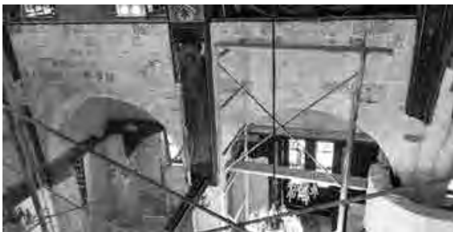
Είκ. 5. Υπερύψωση στο δυτικό τμήμα του ναού (κατά τη διάρκεια εργασιών).
