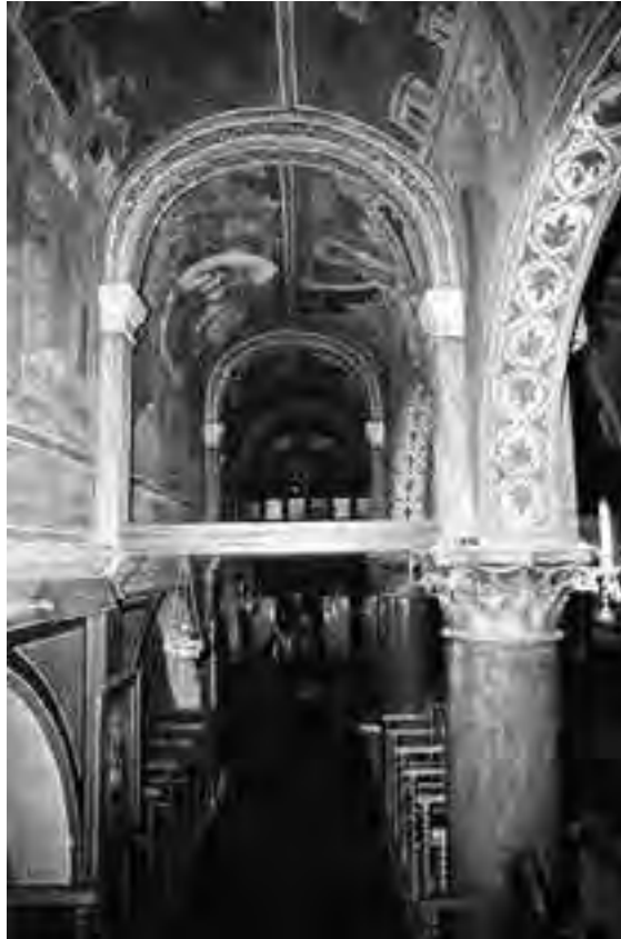
Εικ. 32. Έσωτερική άποψη βόρειου κλίτους καί τοιχογραφιών πρίν τίς έργασίες.
