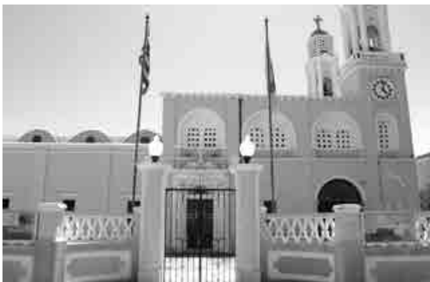
Εικ. 26. Βόρεια άποψη της Μητρόπολης και του αύλότοιχου.
