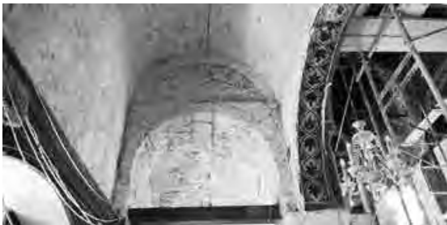
Είκ. 6. Νότιο κλίτος, προσθήκη παταριοῦ μέ γυναικωνίτη (κατά τή διάρκεια ἐργασιῶν).
