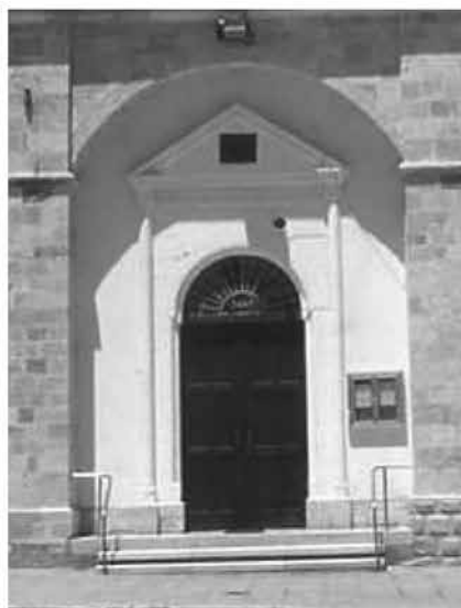
ΚΣΕΚ 22. Νότιο Θύρωμα, Εὐαγγελισμός, Κλήρου Λευκωσίας
