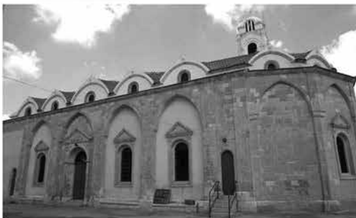
ΚΣΕΚ 24. Ὁ Ἅγιος Γεώργιος, Λύμπια Λευκωσίας μὲ ἐξωτερικὲς ἀντηρίδες, συνδεδεμένες μὲ ἐνδιάμεσα ὀξυκόρυφα τόξα
