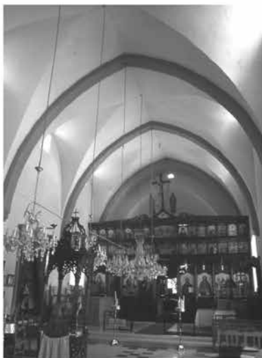
ΚΣΕΚ 12. Ἑσωτερικὴ ἀποψη
