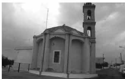
Μὲ 5 ἀκτινωτοὺς ὀξυκόρυφους θολίσκους, ΚΣΕΚ 14. Ἅγ. Ἀνδρόνικος, Εὐλοτύμπου Λάρνακας, ἐξωτερικὴ ἀποψη
